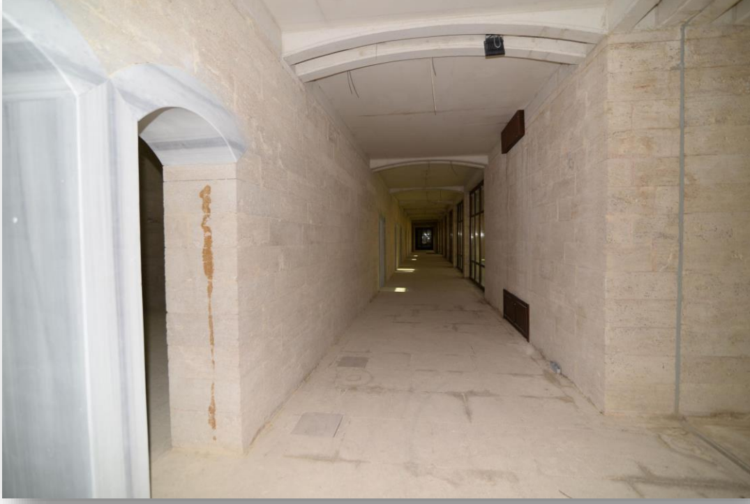
RESİM 7 - Duvarlarda Yaşayan Tablolar Uygulama Alanı
