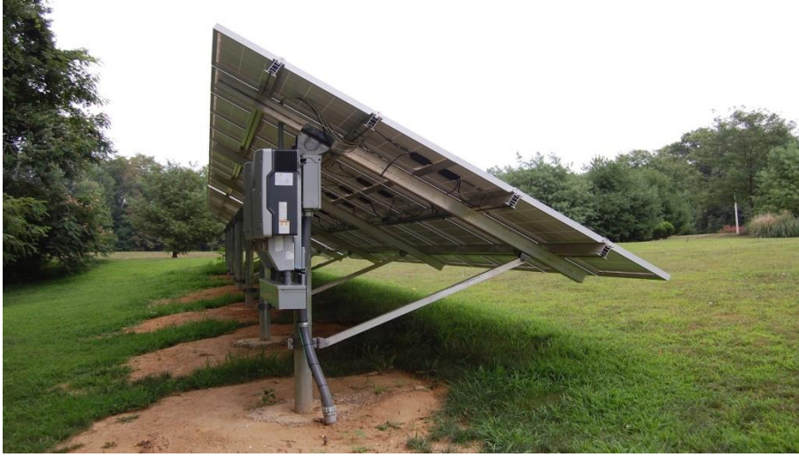
Şekil 3.16. PV panelleri ve elektrik aksamı (18)
