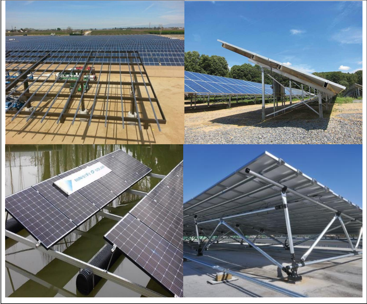
Şekil 3.27. GES sistemi panel montaj sistemleri (27)
