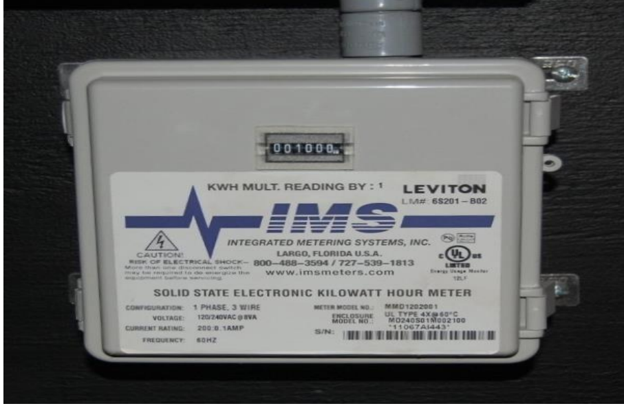
Şekil 3.19. GES sistemi elektrik sayacı (19)
