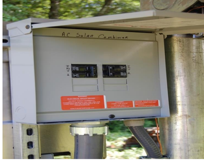
Şekil 3.21. İnverterlerden gelen AC akımı birleştiren kontrol panosu (19)
